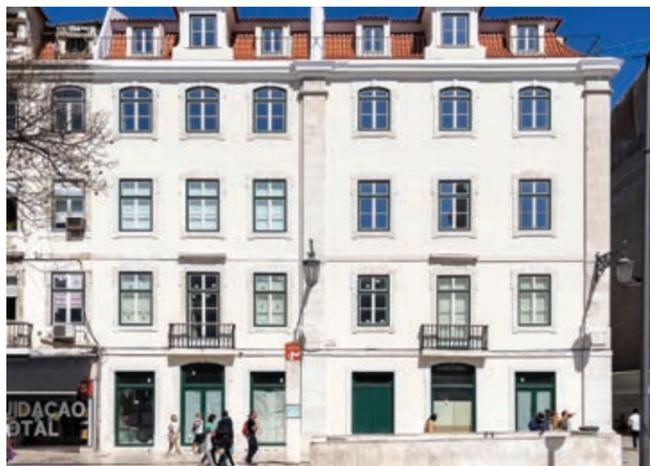
Acabamento à base de cal hidráulica natural em camada fina, com uma textura lisa respirável protegida com esquema de pintura de tinta de silicatos.
