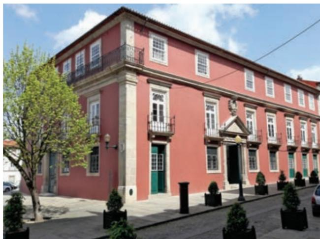
Acabamento colorido à base de cal hidráulica natural em camada areada, permitindo um acabamento de textura rústica com aspeto tradicional.
