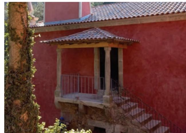
Acabamento colorido à base de cal hidráulica natural em camada fina, permitindo um acabamento liso, de textura suave com aspeto tradicional.
